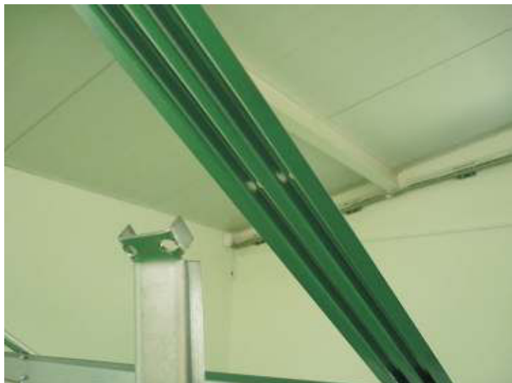
Spojení střešní výztuhy (24) a střešního sloupku (15).
